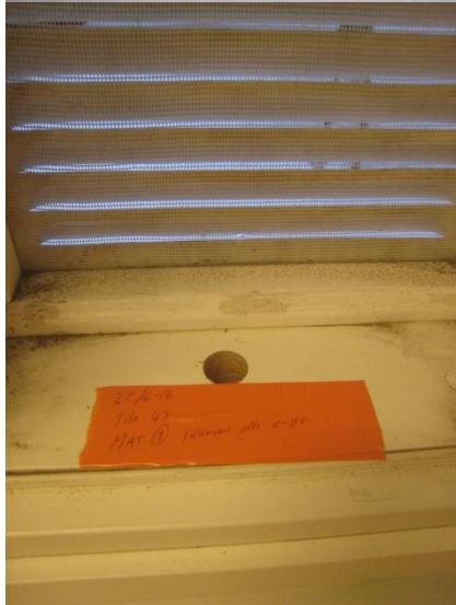
Kuva 9.2; Ulkoseinärakenteiden eristetilasta otettiin materiaalinäytteitä ikkunan karmien kautta.
