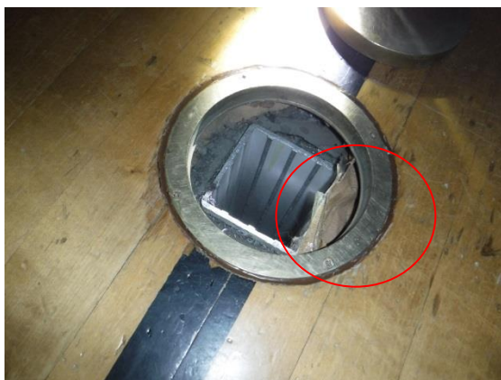
Kuva 8.7; Liikuntasalin lattian telinekiinnike. Lankun alla näkyy pahvi.
