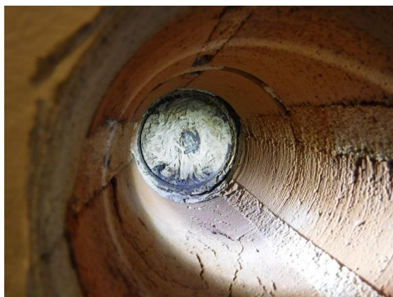
Kuva 7.7; oppilaskunnan tilaan tehty seinäavaus maanpaineeseen. Seinän tiilikerroksen vahvuus 400 mm, takana tojax-eriste.
