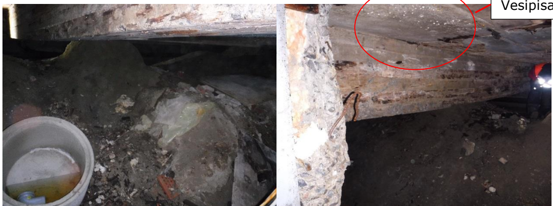
Kuva 8.5; Lukion alapohjassa on edelleen rakennusjätettä. Kosteus tiivistyy pinnoille.
