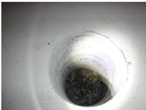
Kuva 8.2; Alapohjaan tehty avaus biologian luokkien läheisyydessä olevassa iv-konehuoneessa. Alapohjan eristeenä kevytsora.
