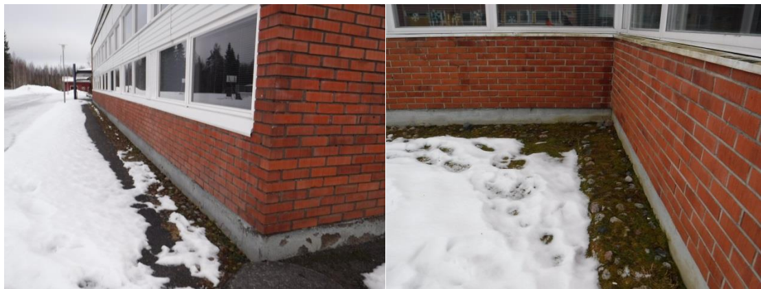
Kuvat 6.1 ja 6.2; Sokkelit ovat silminnähdessä kastuneet ja paikoin pahasti rapautuneet kosteuden vaikutuksesta.
