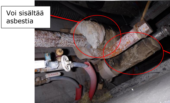
Kuva 8.4; Putkikanaalissa kulkevia talotekniikkalinjoja. Pahveissa on näkyviä mikrobivaurioita. Putkieristeet voivat sisältää asbestia.
