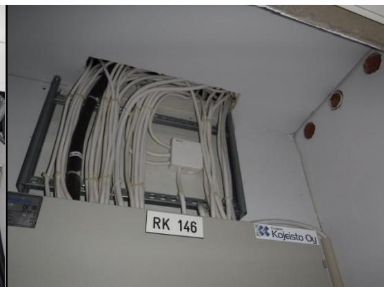
Kuvat 10.9; 10.10 ja 10.11; Sähkökaappien läpivientien tiiveys tulee varmistaa.
