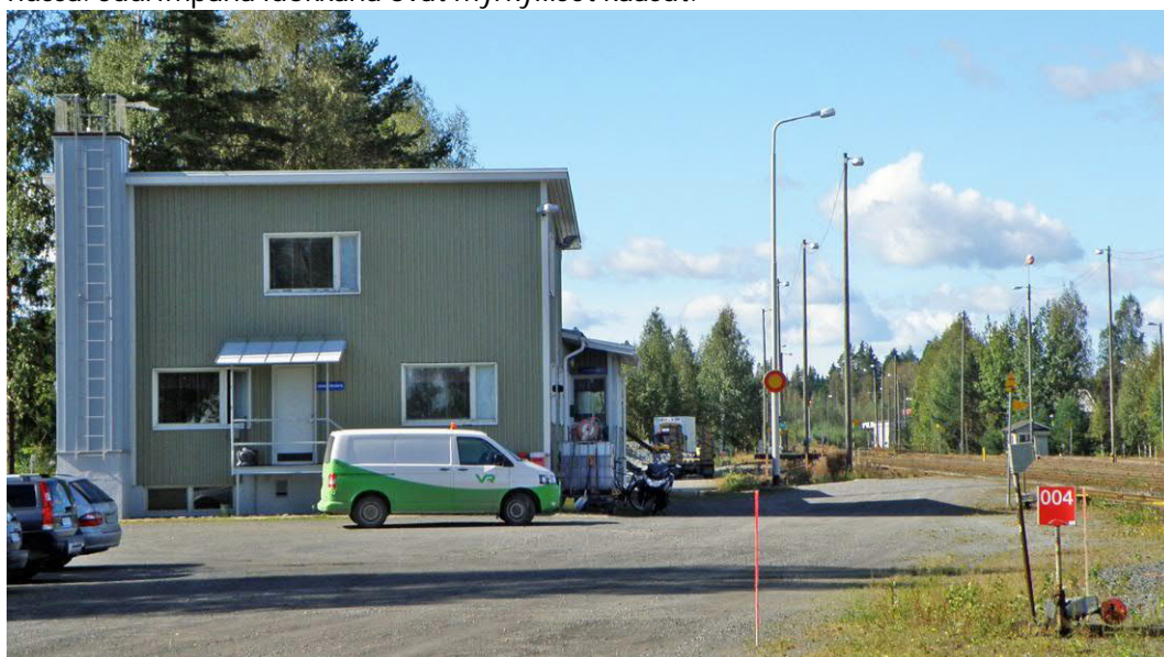
Niiralan ratapihaa rakennuksineen. (Valokuva: [REDACTED] Rejlers Finland Oy)
