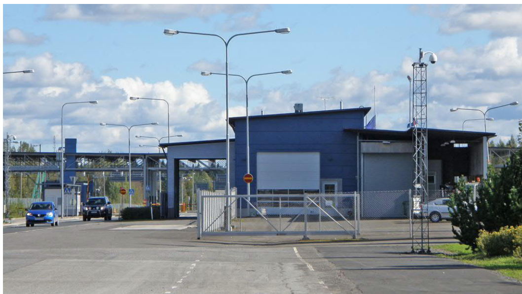
Niiralan raja-asema. (Valokuva: Rejlers Finland Oy)
