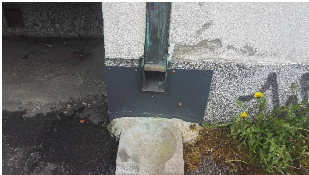
Kuva 2. Sokkeliin asennetut levyt suojaavat sokkeliä roiskevesiltä sekä betoniset sadevesikourut ohjaavat sadevesiä pois rakennuksen viereltä.
