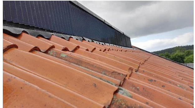
Kuva 25. Betonitiilikate.
