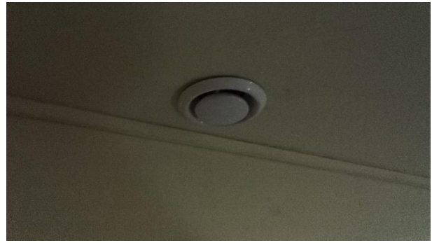
Kuva 41. Poistoilmaventtiili kellarissa.
