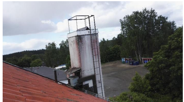
Kuva 27. Takapihan puolella olevat talotikkaat sekä lumiesteet katolla.
