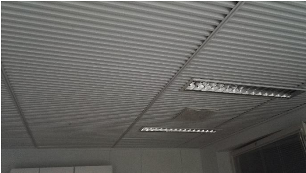
Kuva 34. Alaslaskettu katto 1-kerroksessa.
