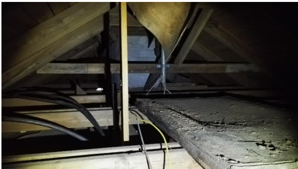
Kuva 20. Yleinen kuva yläpohjasta.
