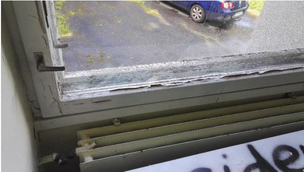
Kuva 30. Ikkunat ja ovet ovat alkuperäisiä.
