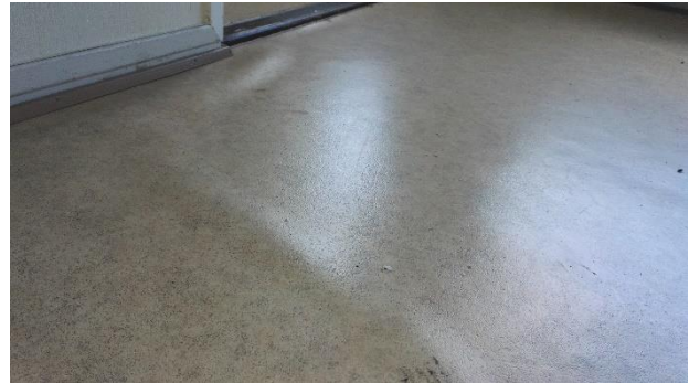
Kuva 11. Muovimatot kupruilivat 2. kerroksen asuinnoissa.
