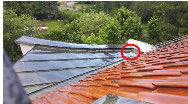
Kuva 3. Kuvassa olevasta syöksytorvesta ei havaittu veden johtumista alas.
