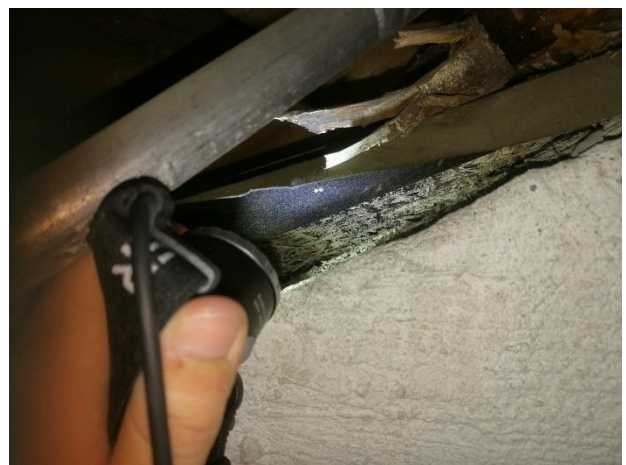
Kuva 23. Porrashuoneen yläpuolella Toja-levyä ja ter- vapaperi
