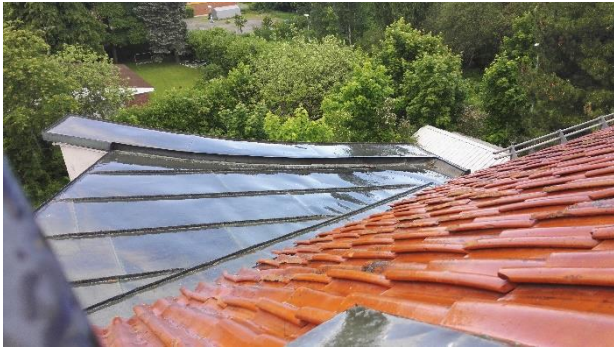
Kuva 24. Kuva otettu tarkastusluukusta.
