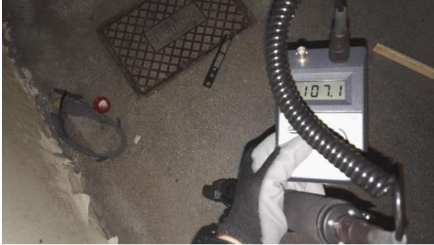
Kuva 7. Alapohjaan tehtiin pintakosteusmittauksia pistokoemaisesti.
