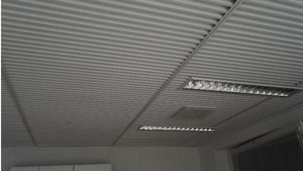
Kuva 11.3 Loisteputket ovat vaarallista jätettä.
