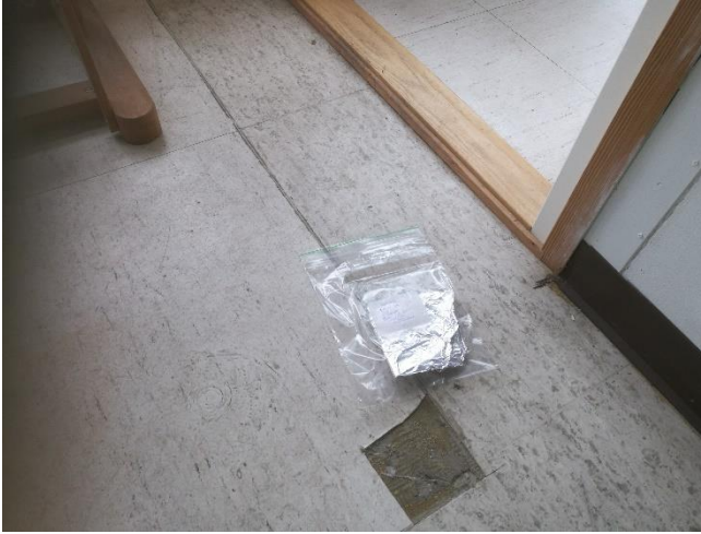
Kuva 8.3 1.krs vanha eteinen, valkoinen muovimatto, raskasmetallipitoisuudet ylittävät haitallisen jätteen ylemmän ohjearvon.
