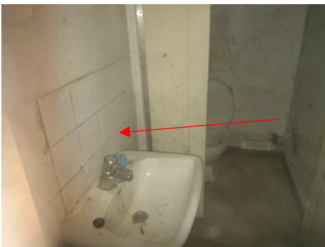
Kuva 4.1 005 tilan seinälaatta, kiinnitys- ja saumalaasti sekä tasoite sisältävät asbestia.
