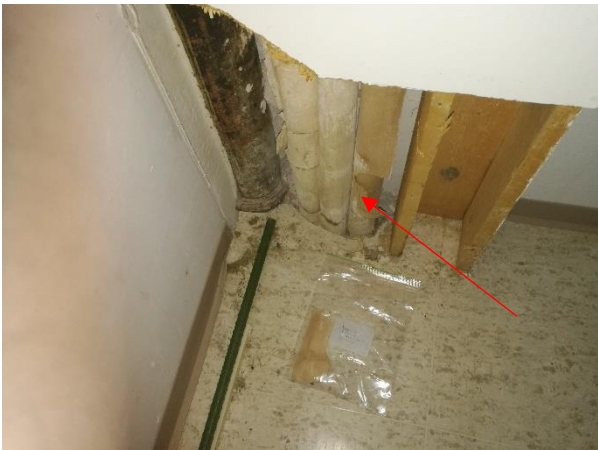
Kuva 6.6 1. krs varasto, putkieriste, ei sisällä asbestia.
