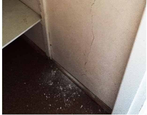
Kuva 8.4 2.krs huoneisto 1, vaatekomo, linoleum, raskasmetallipitoisuudet ylittävät haitallisen jätteen ylemmän ohjearvon ja lyijyn vaarallisen jätteen ohjearvon.
