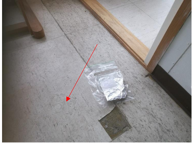
Kuva 6.4 1. krs vanha eteinen, valkoinen muovimatto, ei sisällä asbestia.
