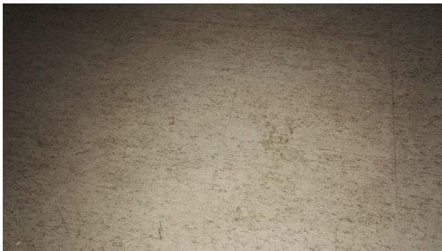
Kuva 8.1. 007 kahvion valkoisen muovimaton, raskasmetallipitoisuudet ylittävät haitallisen jätteen ylempään ohjeavron.
