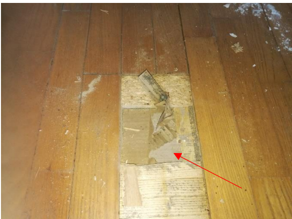
Kuva 6.10 2. krs huoneisto 4, muovimatto parketin alla ei sisällä asbestia.
