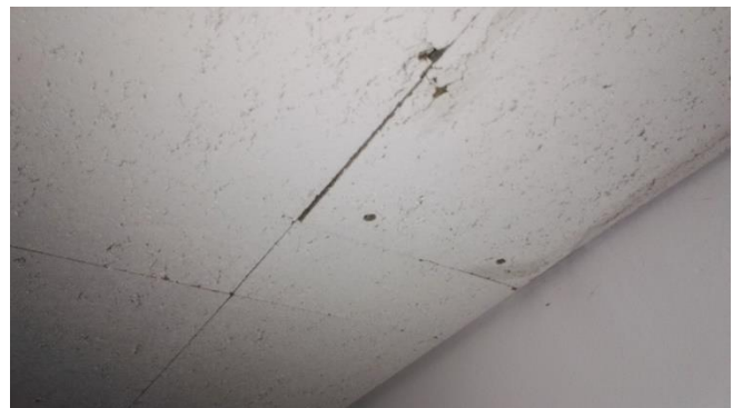
Kuva 6.2 007 Kahvio, alakattolevy, ei sisällä asbestia.
